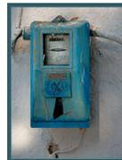
Zähler dieser Art mit Außenwandmontage wurden in den letzten Jahren in den USA durch elektronische Zähler ersetzt.
